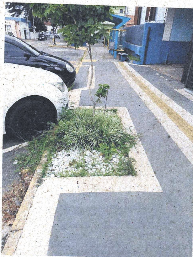
Figura 8 Detalhe esquerdo da calçada
